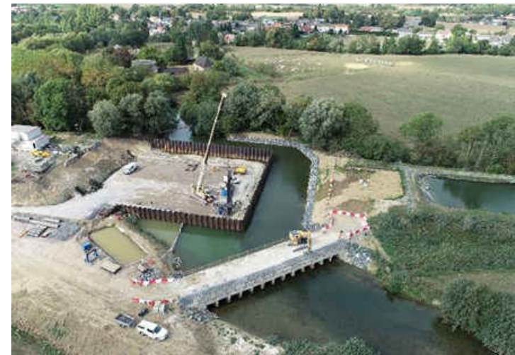
Fig.2: Steel sheet piles employed in Vadencourt – France© Patoux Travaux Spéciaux
