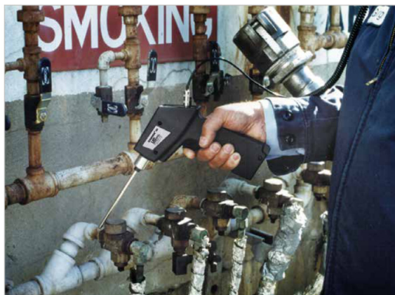
蒸気トラップの点検
