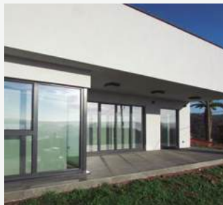
Passiivitalo. Asuinrakennus. Miño, Espanja. Aquarea.
