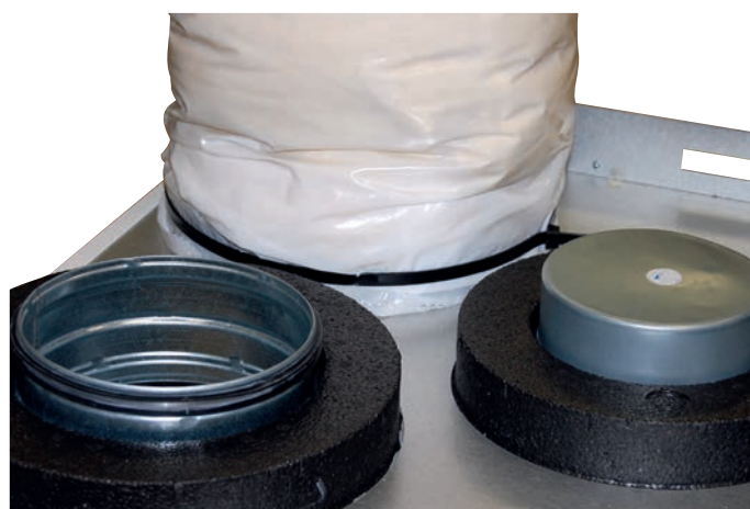
Valmiiksi asennettu kanava.
