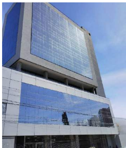
Nuevo edificio Avellaneda
