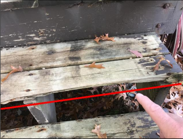
1.3 Broken Step Edge
