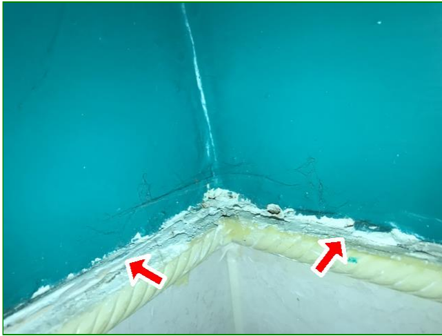
Item 11 - Deteriorating Caulk
