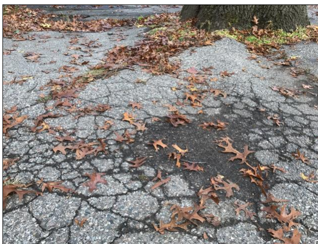
1.0 Cracking & Uneven Asphalt
