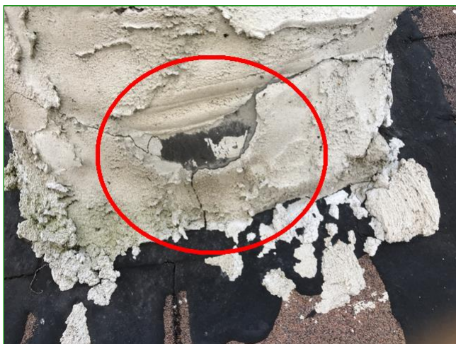
Item 4 - Deteriorating Stucco
