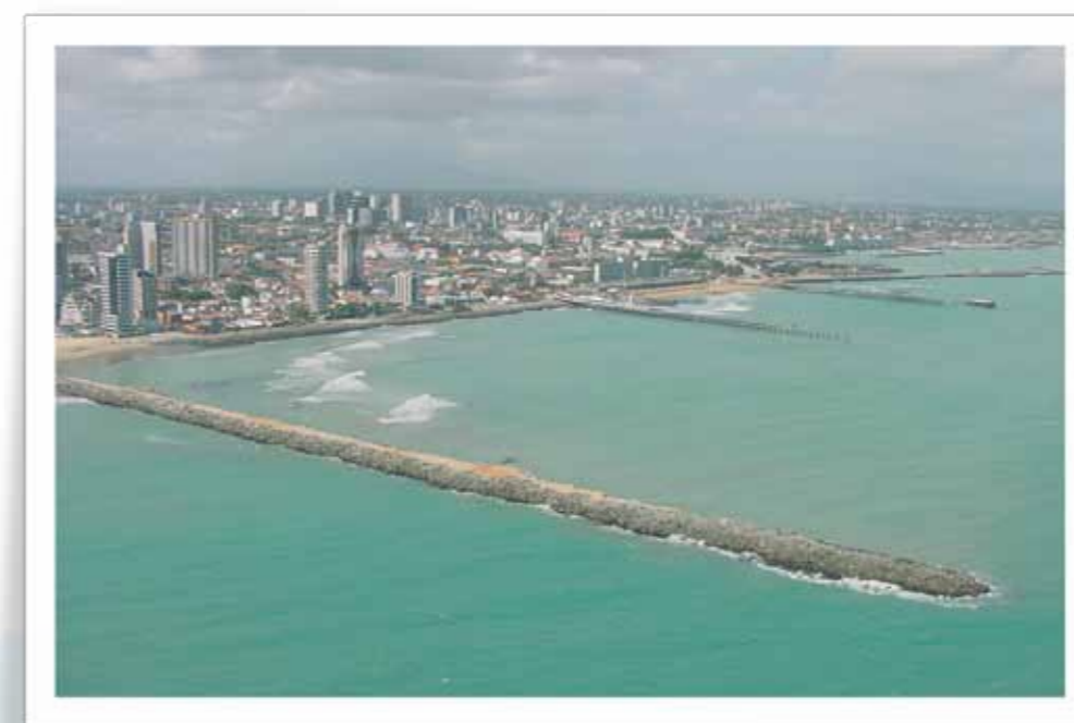
Obras de contenção à erosão costeira, Fortaleza, CE.
