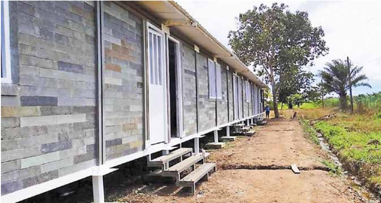
La empresa colombiana ‘Conceptos plásticos’ fabrica viviendas con bloques de plástico tipo Lego que facilitan su construcción.
