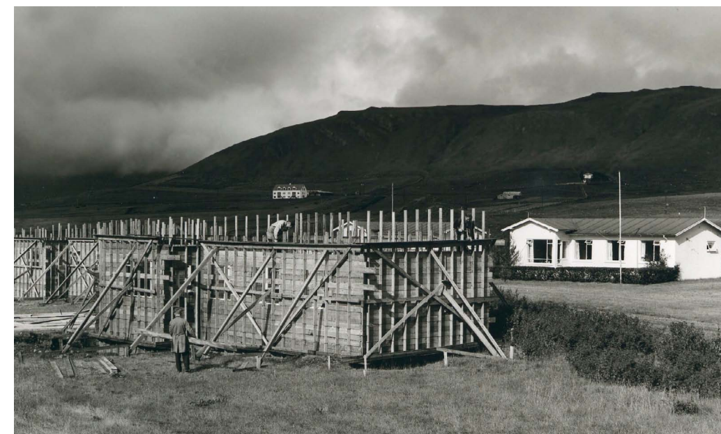
Hér má sjá tvö hús í byggingu við Neðribraut, líklega þau sem Geðverndarfélagið reisti á Reykjalundi.
