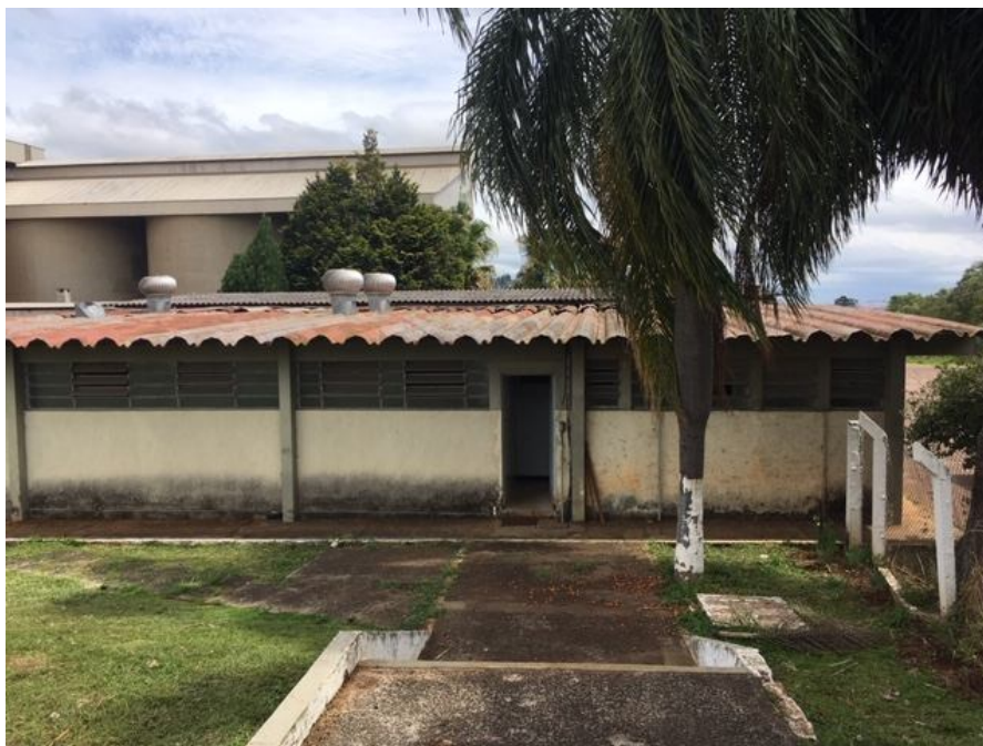
Foto 10: Situação dos prédios (externo)
