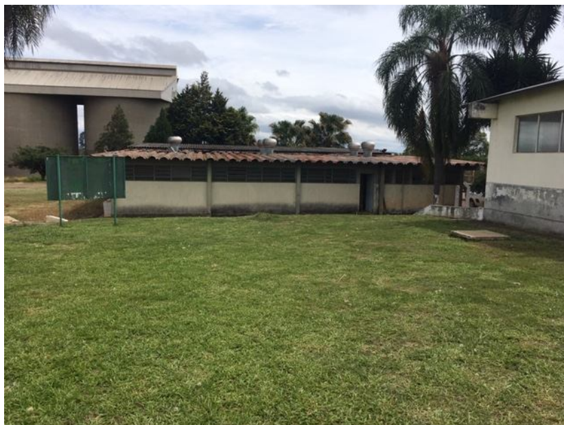
Foto 6: Situação dos prédios (externo)
