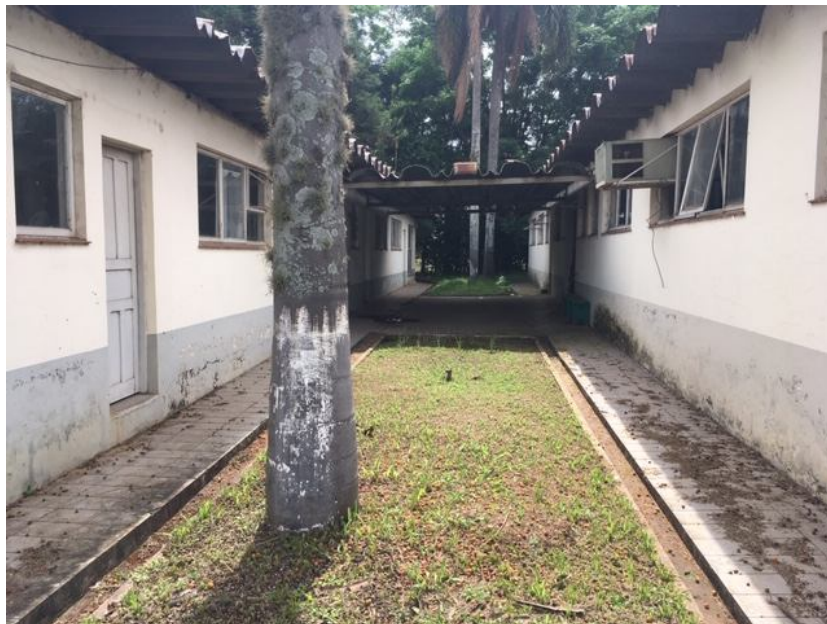
Foto 9: Situação dos prédios (externo)
