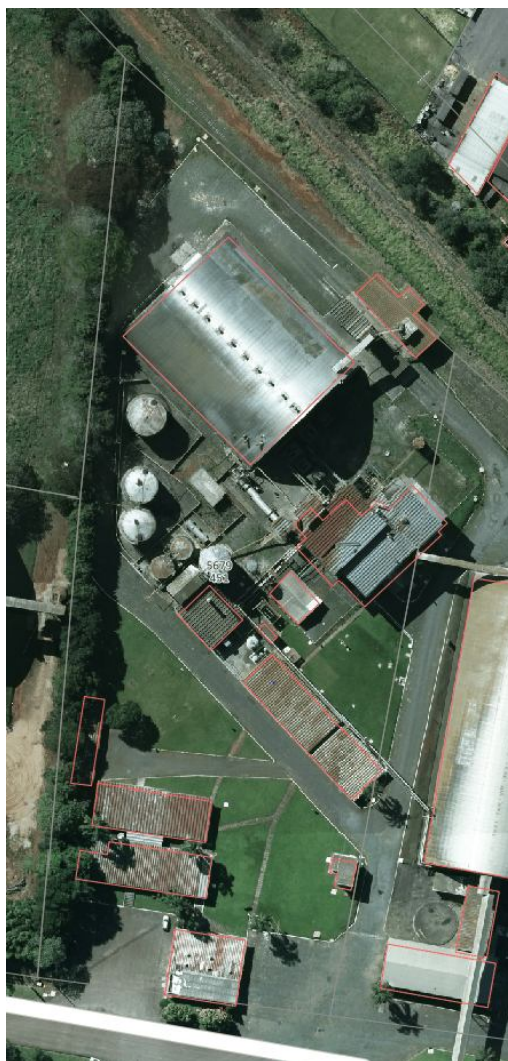
Foto Aérea do Geoweb
