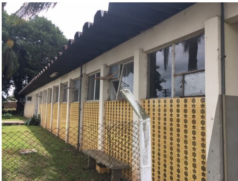
Foto 4: Situação dos prédios (externo)
