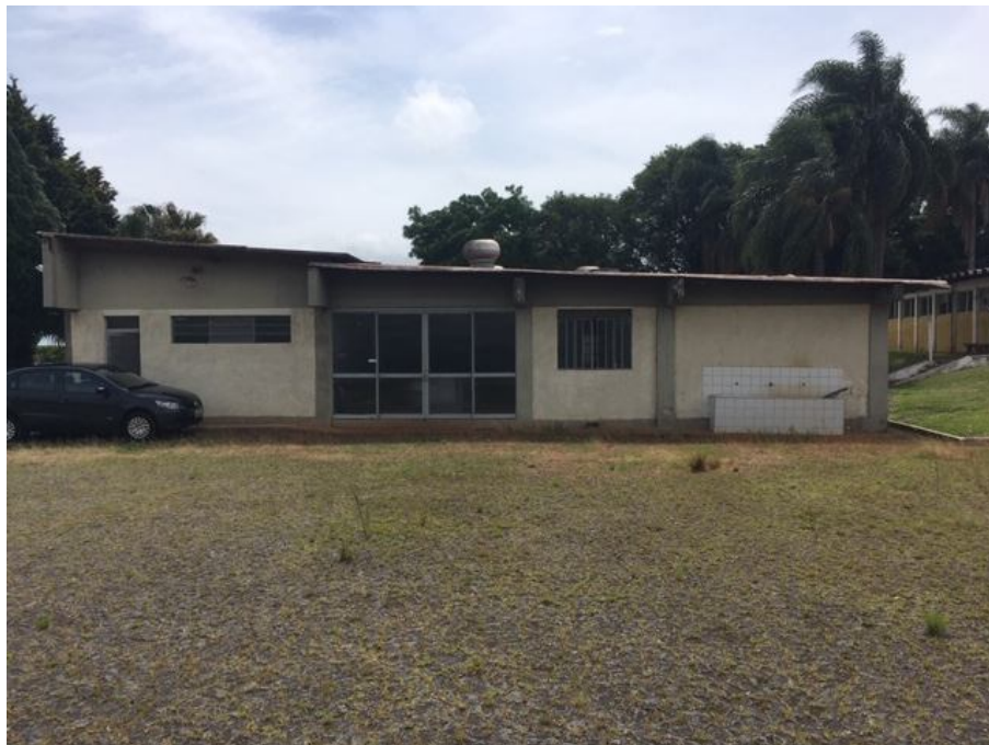
Foto 10: Situação dos prédios (externo)
