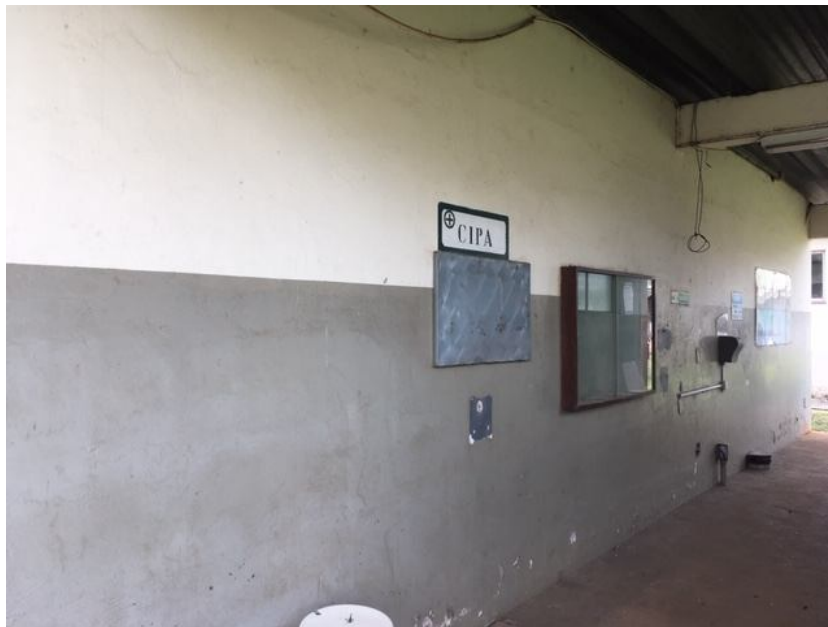
Foto 5: Situação dos prédios (interno)
