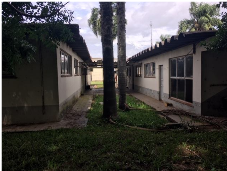
Foto 8: Situação dos prédios (externo)
