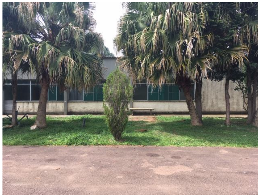
Foto 2: vista da antiga estrada (lateral do prédio principal)
