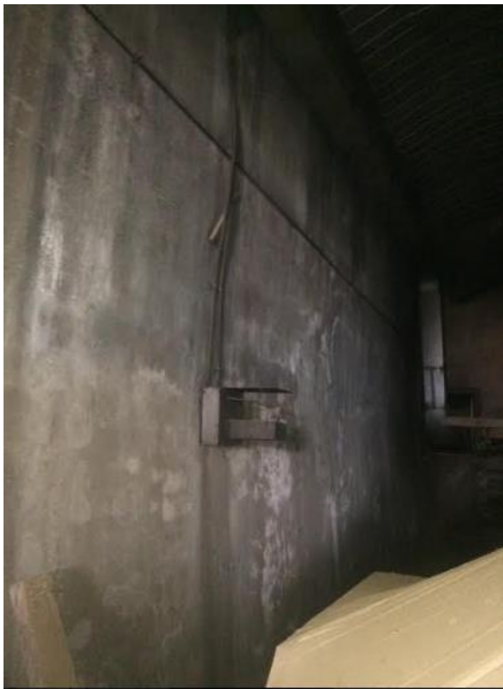
FOTO 06 – Dutos de recirculação.
