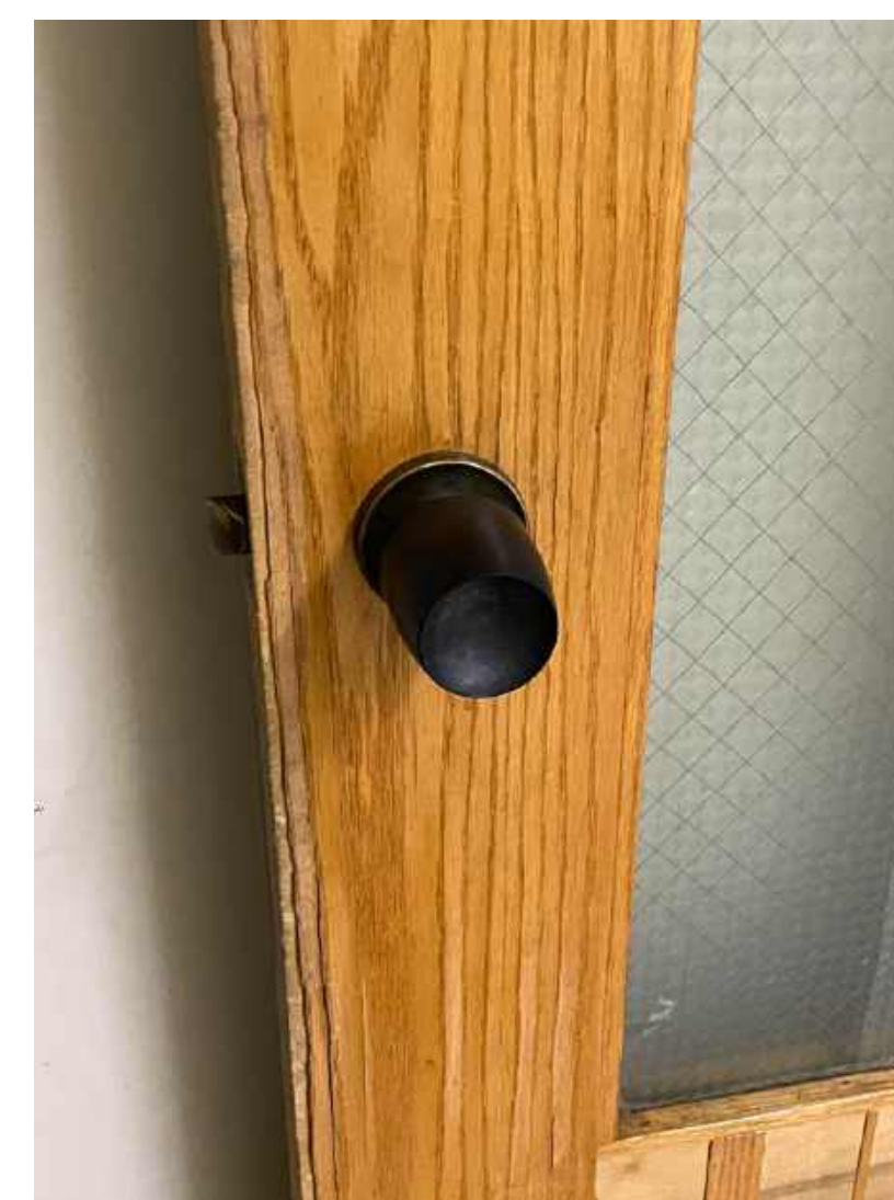
Door knobs/De-laminated doors
