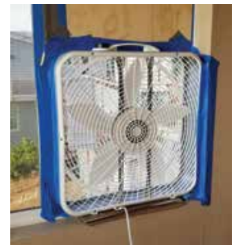
box fan blowing OUT
