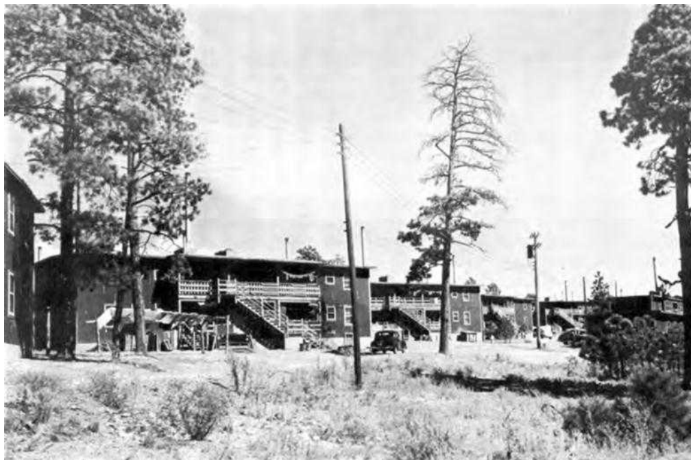
Figura 22.4. Unități de apartamente pentru patru familii la Los Alamos, 1945
