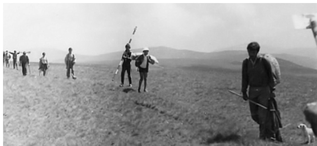
Fig.206 Ciment, nisip spre Gropșoara
