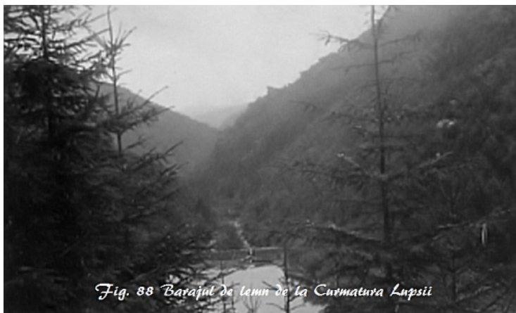
Fig.88 Barajul de la Curmătura Lupșii
