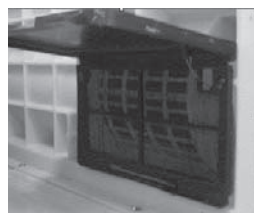
Ilustración B – Extracción del filtro de ventilación
