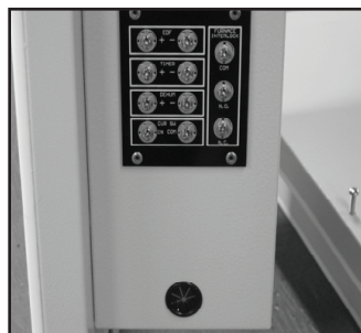
Figure 6 Insérez les fils du moteur du volet à travers la douille
