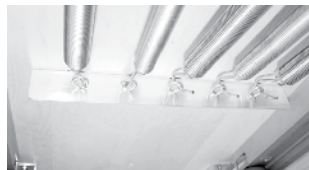
Abb. 3: Federhaken zeigen nach unten
