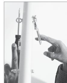
Figur 9: Använd två fingrar för att dra åt bultarna
