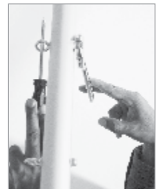
Figure 9: Serrez les boulons avec deux doigts
