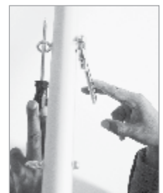
Abb. 9: Mit zwei Fingern die Schrauben festziehen
