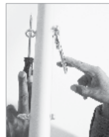
Figura 9: Usare due dita per stringere i bulloni
