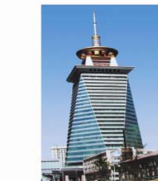
天津电信 Tianjin Telecom
