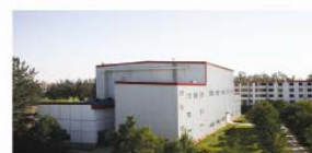
火灾实验测试中心 Full-scale Fire Test Center
