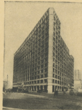
Holland Plaza Bldg. New York City, N. Y. Archts.: Buchman & Kahn
