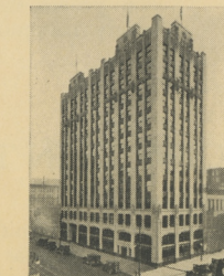
Security Bldg. Denver, Colo. Archts.: W. E. & A. A. Fisher
