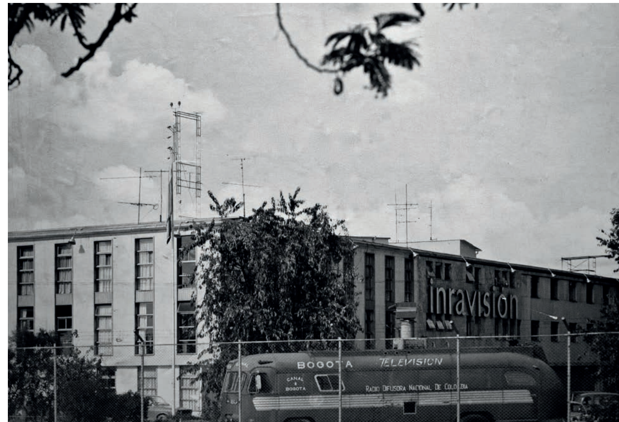
Edificio de Inravisión en el CAN (Bogotá) Archivo Señal Memoria
