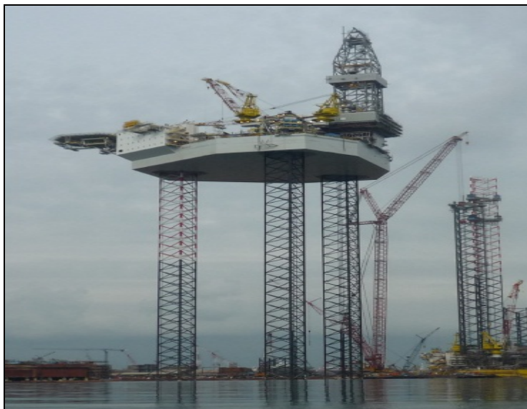
Hình 1.9 Giàn khoan NAGA 2 sẽ khoan trong giai đoạn 1
