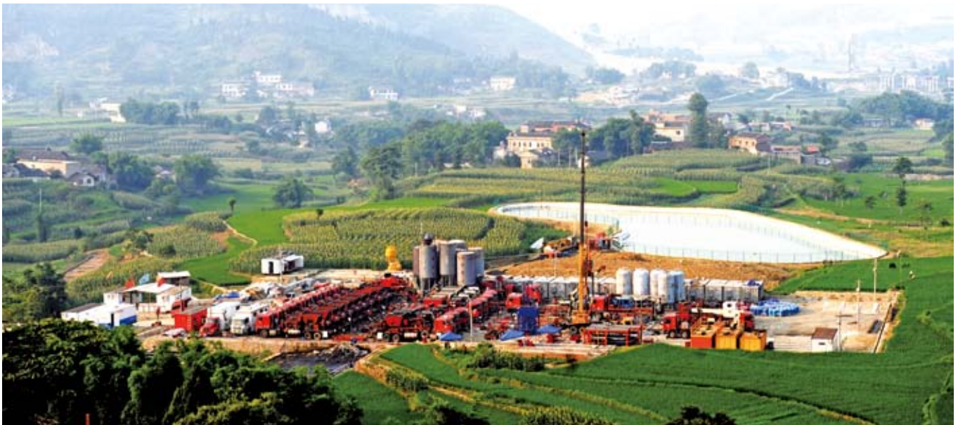
四川威远页岩气大型加砂压裂作业
