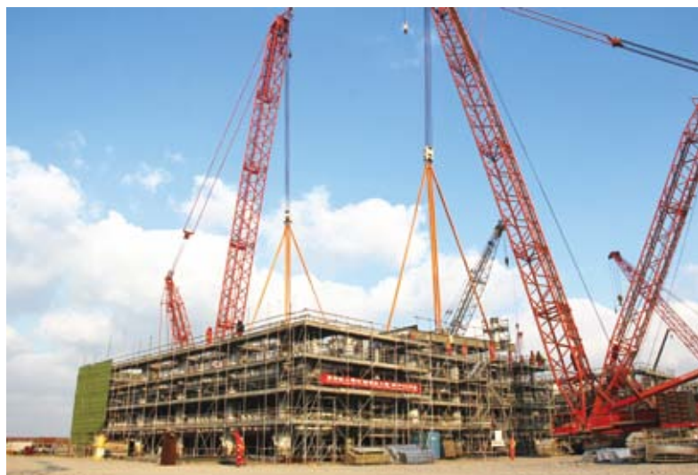
亚马尔项目MWP4工程包建设施工
