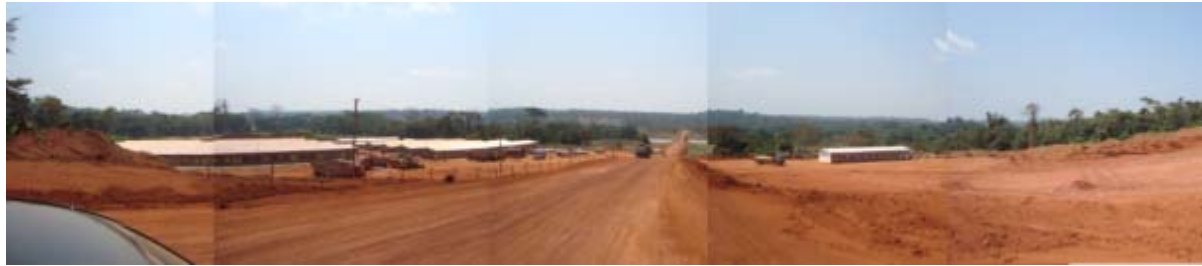
Figure 9.2: Vue du Site de Construction EDC en Direction du Sud vers la rivière Pangar
