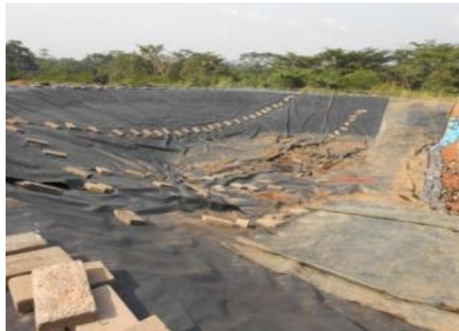
Figure 6.6: Décharge des Déchets Dangereux Rouverte en Novembre 2012
