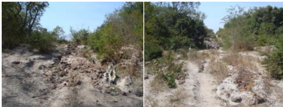
Figure 5.23: Réparation de l'érosion à KP79
