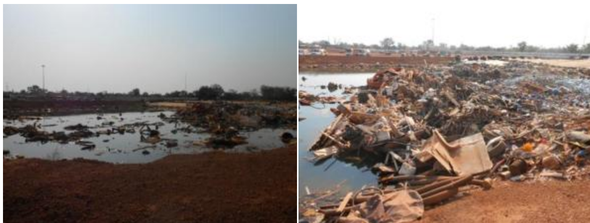
Figure 5.18: Cellules des déchets non dangereux inondées au centre KWMF
