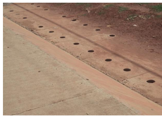
Caniveau à ciel fermé(ou dallé) avec bouche d'aération
