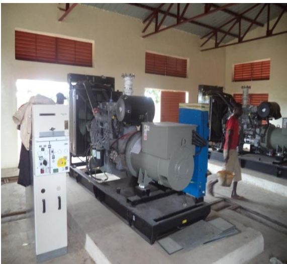
Centrale Electrique de Bodo : Générateur et armoire
