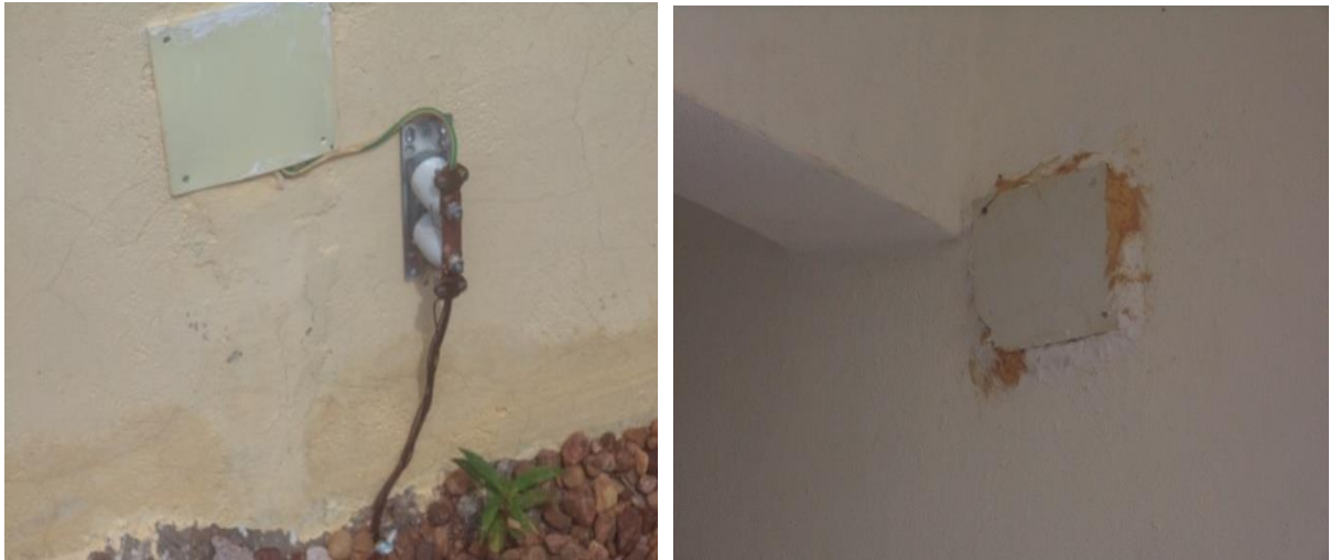
Ecole Primaire de Beguere : prise de terre et boîtier de connexion
