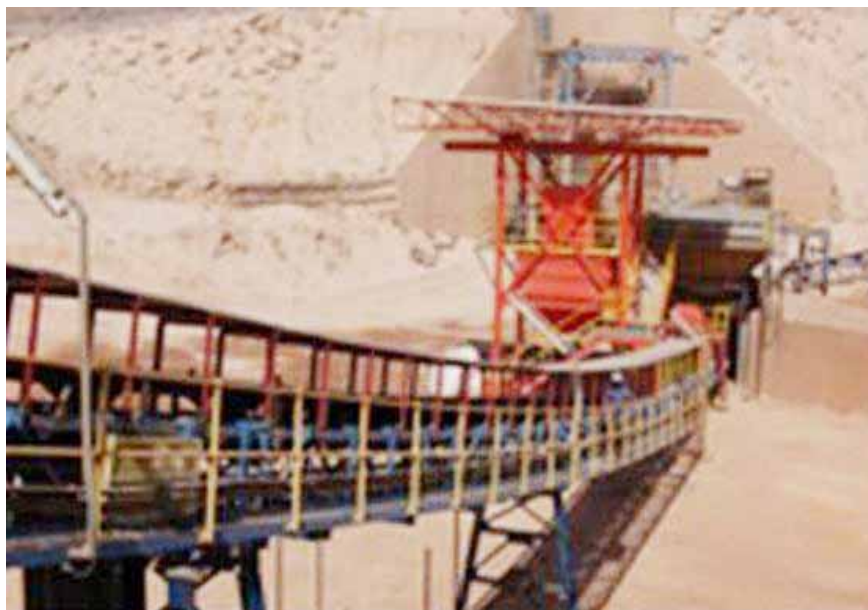
UNE VUE DES INSTALLATIONS DE LA SML
