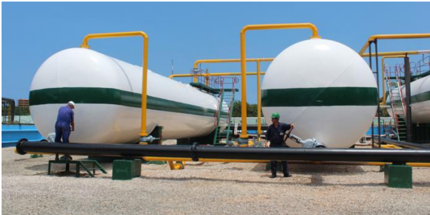
El Centro Colector No.10 de Varadero expone las mejores prácticas del sector petrolero en Cuba. Foto: Cortesía de Cupet
