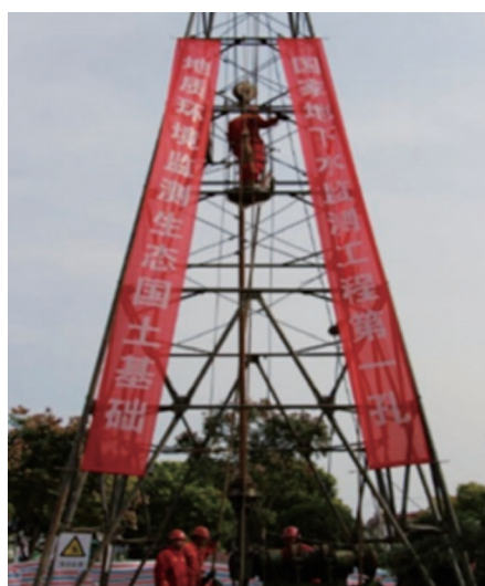
图7-13 国家地下水监测工程启动施工
