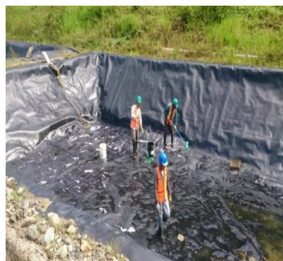
“Limpieza de fosas de perforación, pozo Balam 1X”
