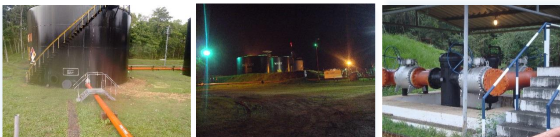
Mantenimiento del tanque Rax-4.5K-01 y recorrido a la estación Raxruhá
