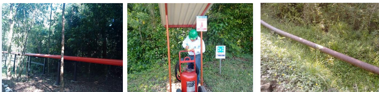
Recorrido al oleoducto e inspección y auditoría a las instalaciones de la estación de bombeo Río Frío
