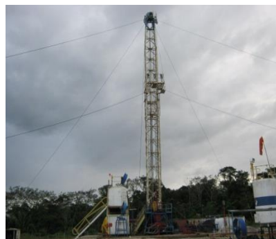
“Torre de perforación en campo Atzam”
