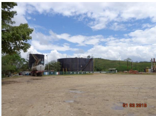
“Tanques Almacenamiento Crudo” Contrato Petrolero 1-91
