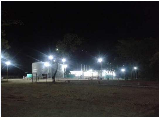
“Planta de Generación Xan” Contrato Petrolero 2-85
