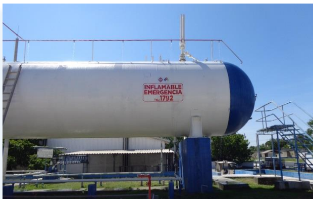
“Instalación de planta de almacenamiento y llenado de GLP”
