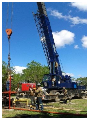
“Intervención Pozo” Contrato 2-2009
