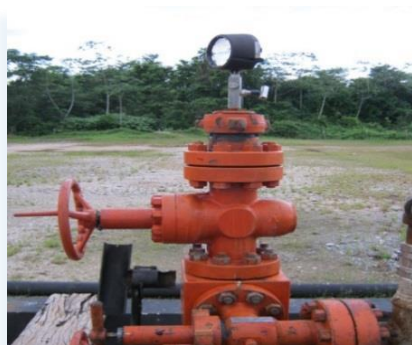
“Cabezal del Pozo Atzam 4”
