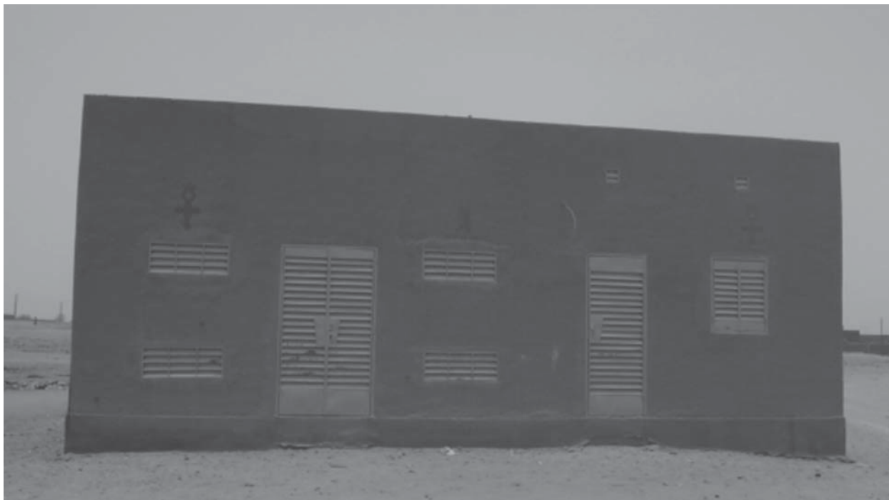
Photo 1 : Bâtiment construit sur le site du parking municipal d'Agadez
