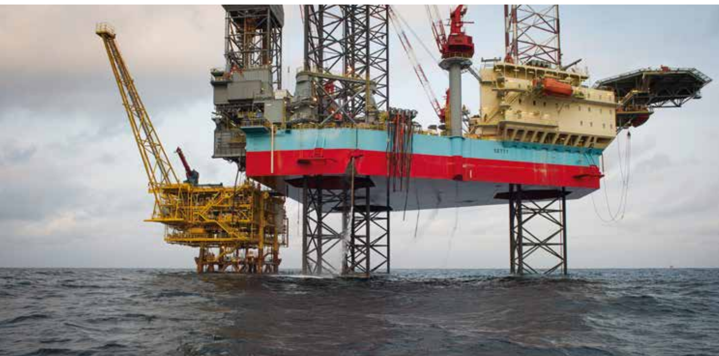
Plateforme AGM-N et rig de forage SETTY au large de Port-Gentil.
