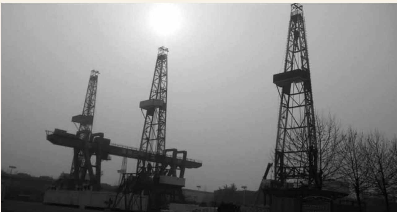
> Vista de los tres equipos armados en China
