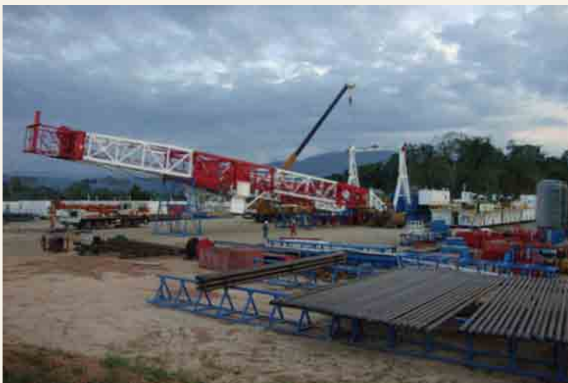
➤ Equipo YPFB-01 Izaje del mástil en pozo BBL-16D
