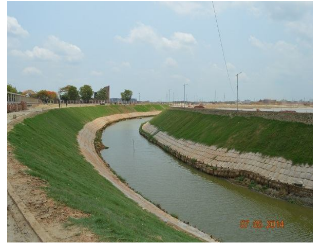
সদ্যনির্মিত রায়ের বাজার কবরস্থান প্রকল্পে খাল সংরক্ষণবাঁধ
