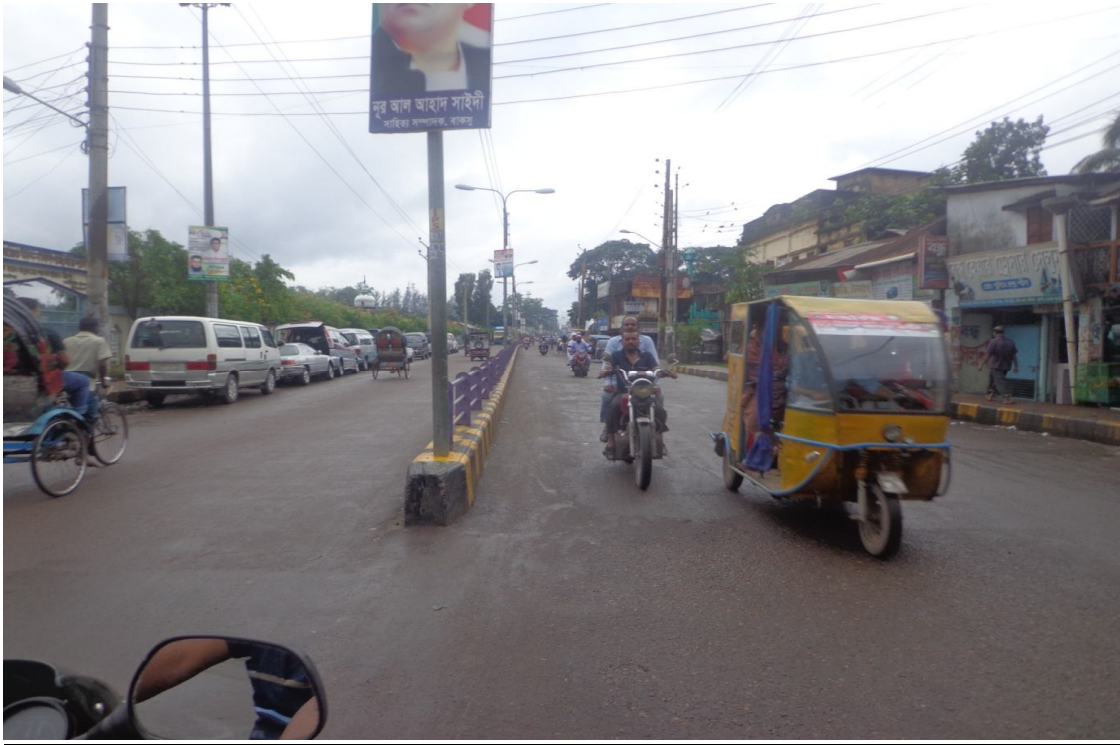
সড়ক নির্মাণ কাজ।
