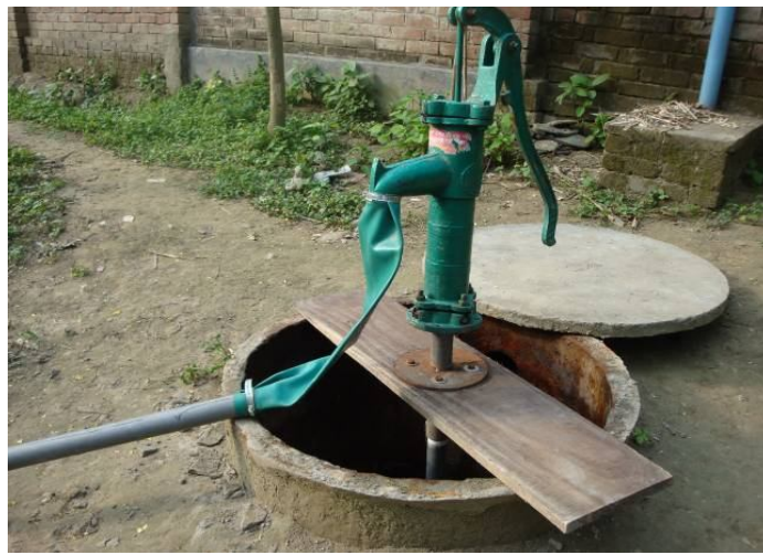
চিত্র নং ১৪ : ৬নম্বর হস্তচালিত পাম্প দ্বারা পিটের ময়লা নিষ্কাশন
