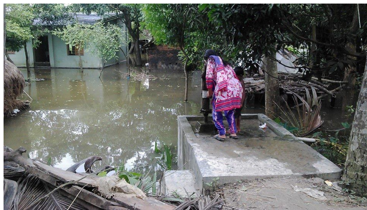
চিত্র নং ১১ : ডিপিএইচই কর্তৃক স্থাপিত উঁচু পাটাতন যুক্ত টিউবওয়েল, মনিরামপুর উপজেলা, মন্দিম নগর ইউনিয়ন, যশোর।
