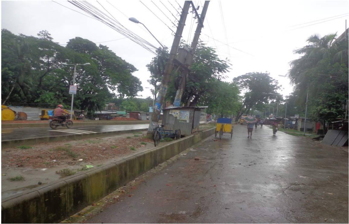
সড়ক নির্মাণ কাজ।
