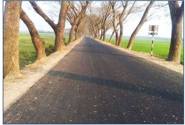
সময়ান্তর রক্ষণাবেক্ষণের পর চৌগাছা - মহেশপুর সড়ক, উপজেলাঃ চৌগাছা, জেলাঃ যশোর।
