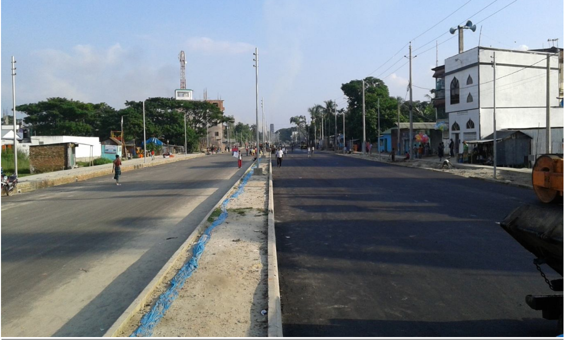
‘Infrastructure Improvement & Procurement of Vehicle & Equipment in Narayanganj City Corporation’ শীর্ষক প্রকল্পের আওতায় নির্মাণাধীন নারায়ণগঞ্জ সিটি কর্পোরেশনের মদনগঞ্জ পাওয়ার হাউজ হতে ত্রিবেণী ব্রীজ পর্যন্ত দুই পাশে আর সি সি ড্রেন ও ফুটপাথসহ ১০০’-০” প্রশস্ত কার্পেটিং রাস্তার একাংশ।
