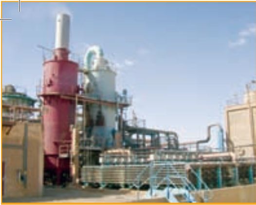
Vue de l'atelier de fabrication d'acide sulfurique
