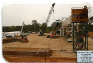
PETROCI USA, Forage du puits MH Hall-3
