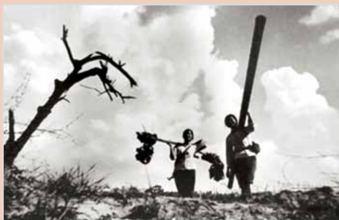
Chuyển đường ống tới nơi lắp đặt
