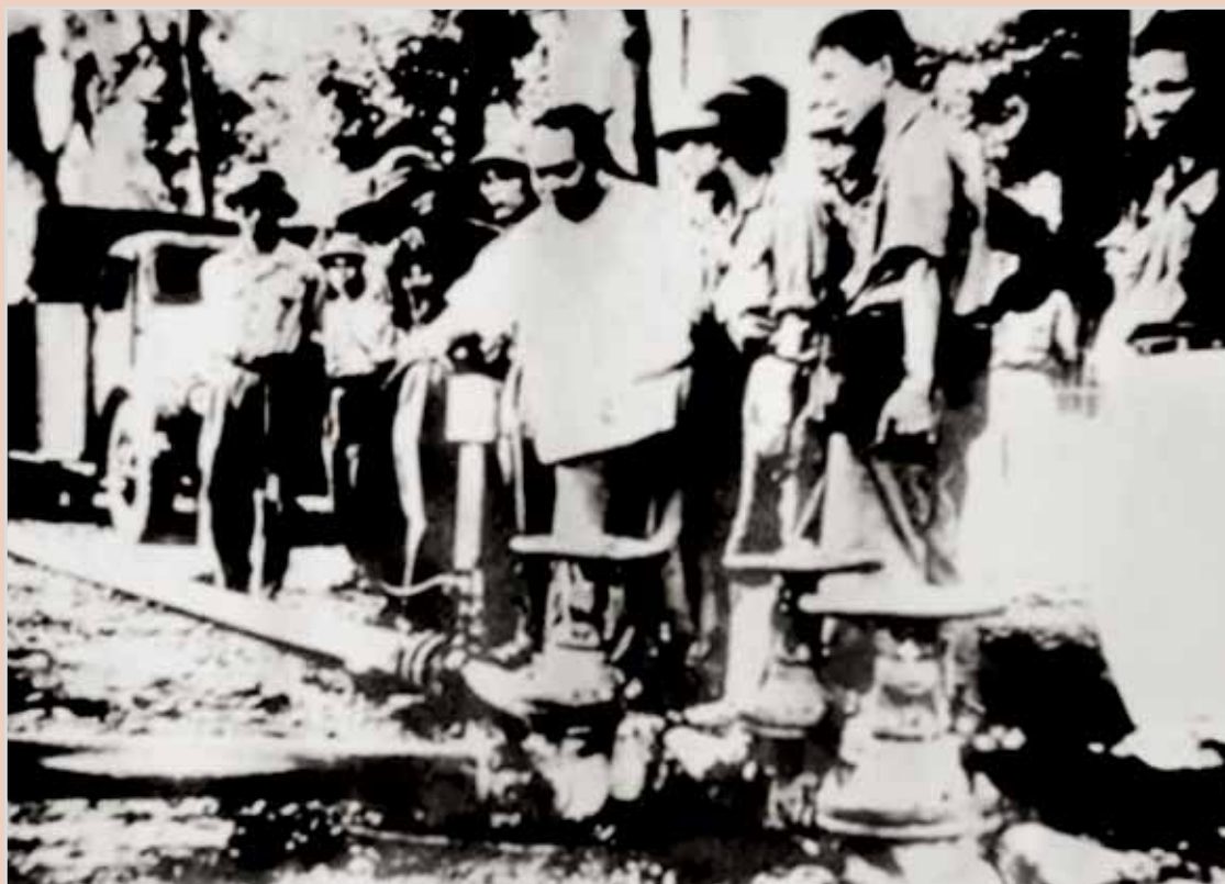
Đại tướng Võ Nguyên Giáp thị sát thi công
