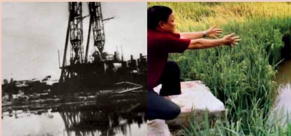
Lắp ráp máy khoan 4LD-150D và nền khoan GK-100 còn lưu lại trên cánh đồng lúa làng Khuốc, huyện Tiên Hưng, tỉnh Thái Bình
