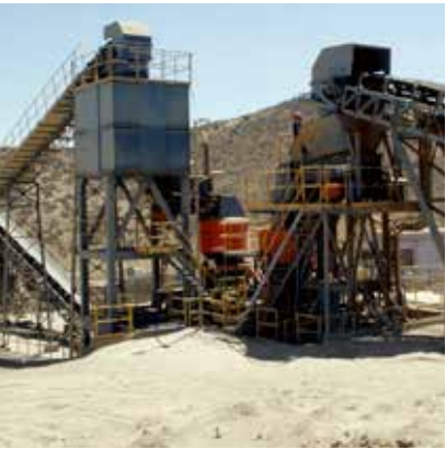
Instalaciones de las operaciones de chancado en Planta Complejo Delta, en Ovalle.
