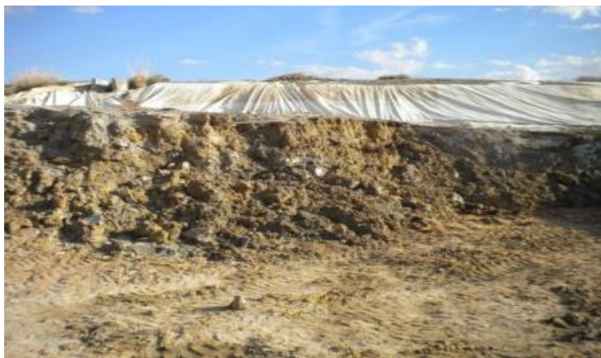
Travaux de remise en état du site de forage du puits MBA#2
