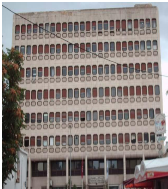
Ancien Siège de l'ETAP
