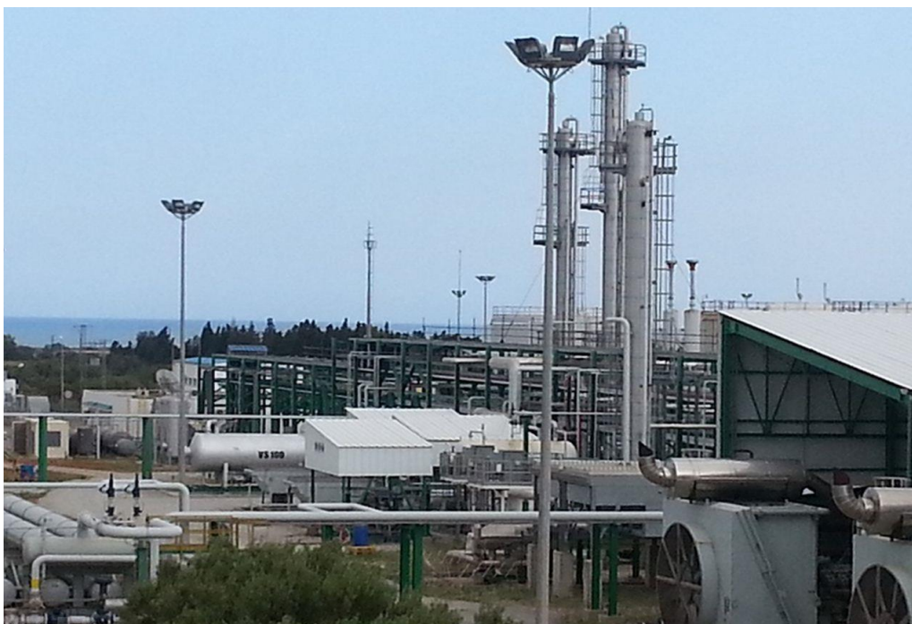
Usine de traitement de gaz Tazarka
