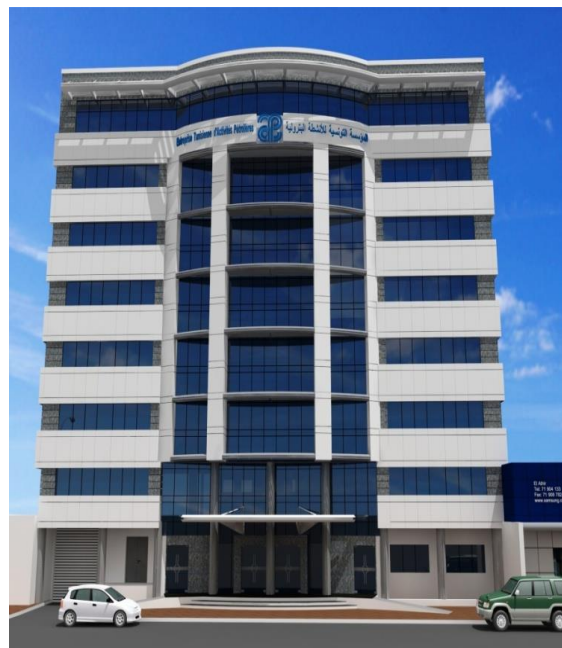
Etat du Siège prévu après rénovation
