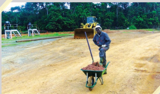
Le site après remise en état. A l'arrière, les puits de production du pétrole de Remboué 2014.
