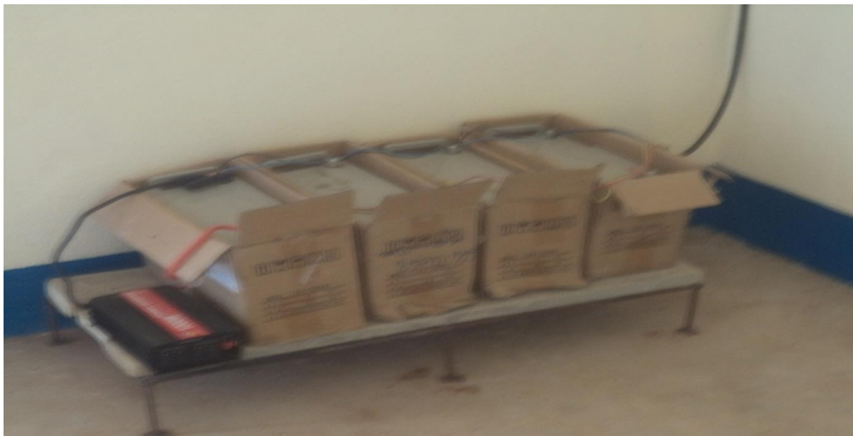
Batteries de charge alimentées par des panneaux solaires
