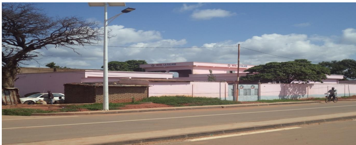
Terre-Plein Central, chaussée et lampadaires solaires
