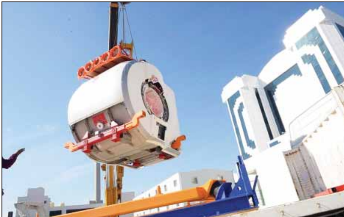
• نقل جهاز التصوير بالرنين المغناطيسي بواسطة الرافعات
