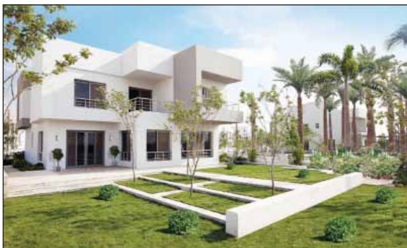
● إحدى فيلات المشروع
