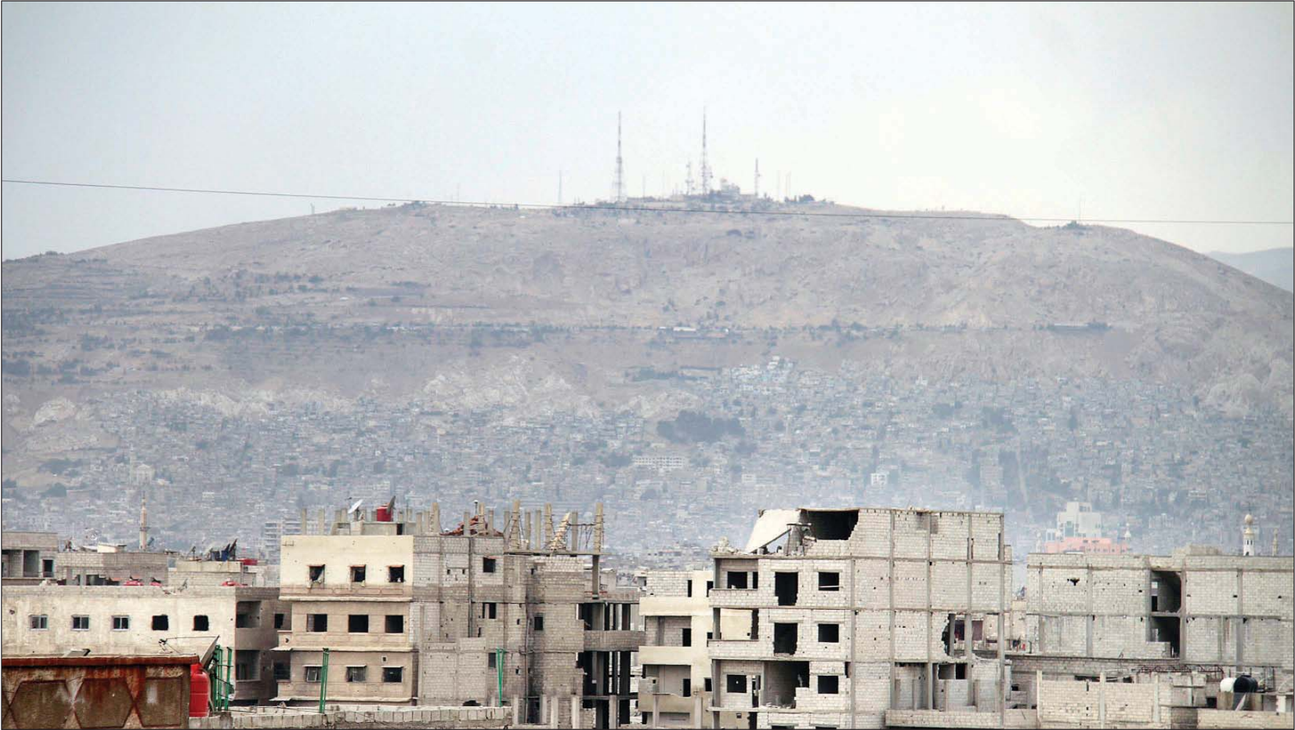
● صورة لجبل قاسيون حيث توجد المواقع السورية التي تعرضت للقصف
