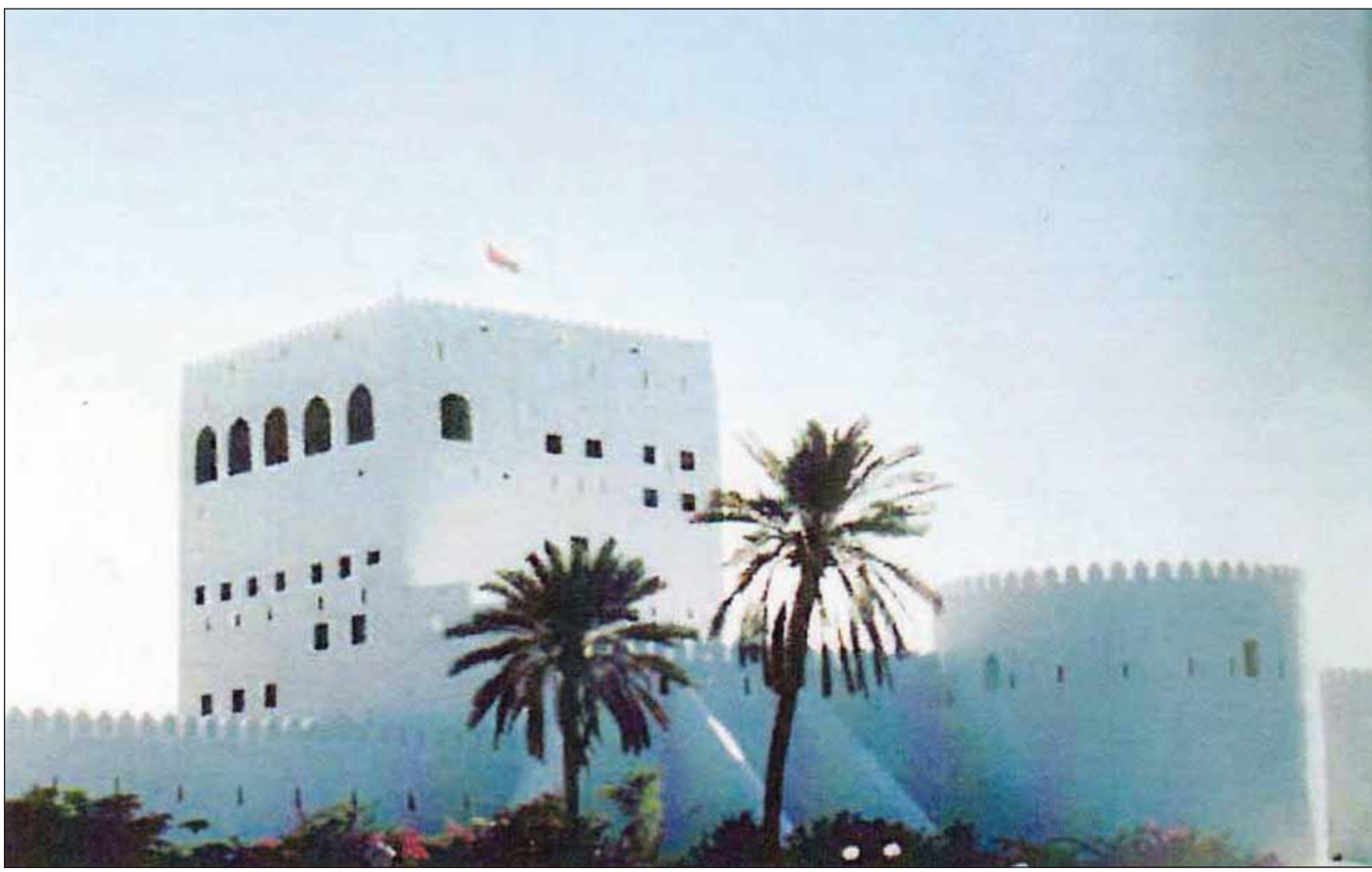
● القلعة قبل الترميم
