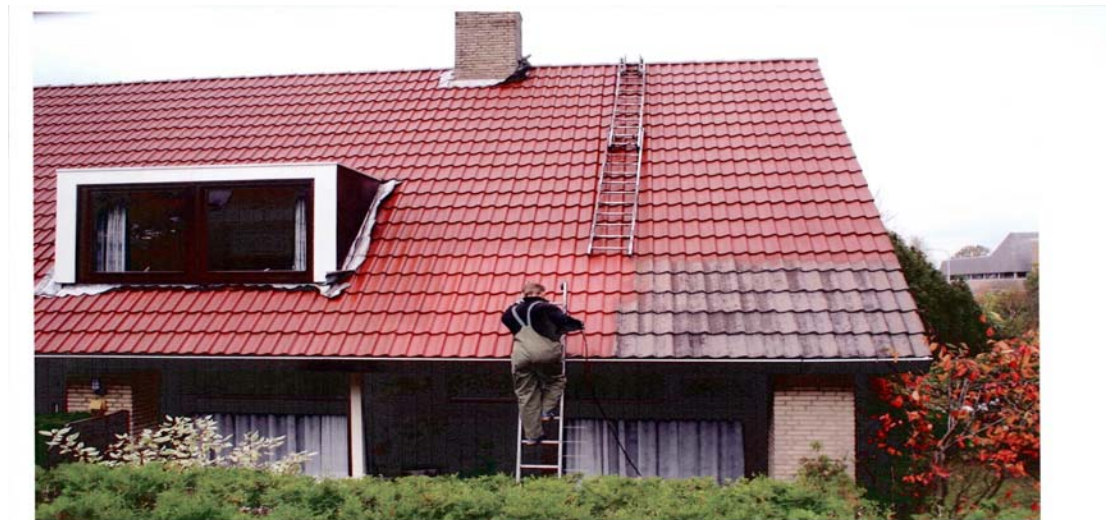
Dachsanierung – rechts unten = unbehandelte Fläche
