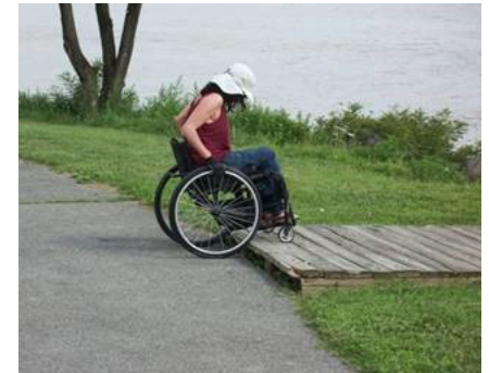
No se provee una ruta accesible para acceder a la acera.
