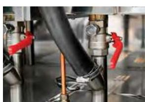
Sistema de drenaje conectado directamente al alcantarillado.
