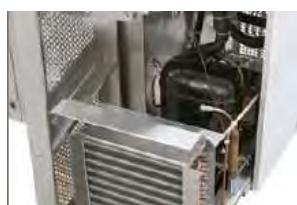
Unidad de refrigeración extraíble para facilitar el mantenimiento. Motor de fácil acceso y con ventilación frontal, que permite posicionar otros equipos en los laterales y en la parte trasera.
